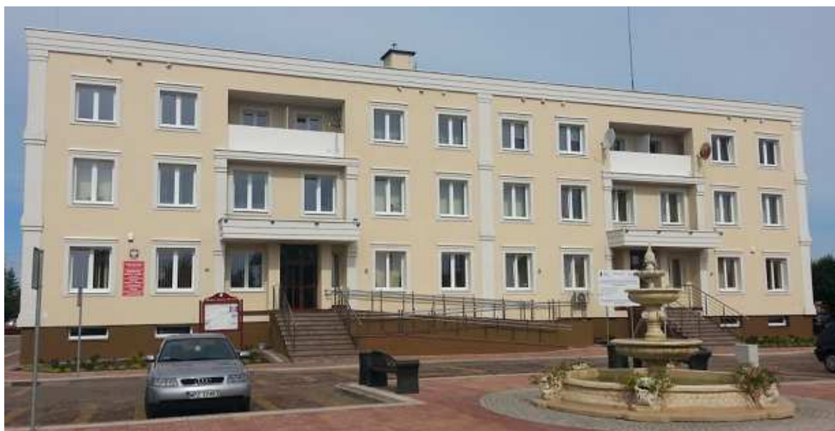
Widok budynku administracyjno-mieszkalnego od strony wschodniej
